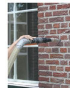
Supafil est insufflée via les orifices dans les murs creux du bas vers le haut.
