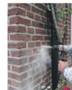
L'installateur agréé choisit l'embout adéquat et fore des trous aux croisements de joints dans le mur suivant un schéma de forage spécifique.
